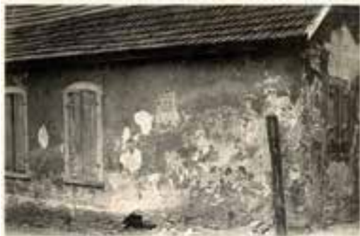
Zustand der ehemaligen Synagoge – Zeit der Aufnahme unbekannt. Foto: Yad Vashem
